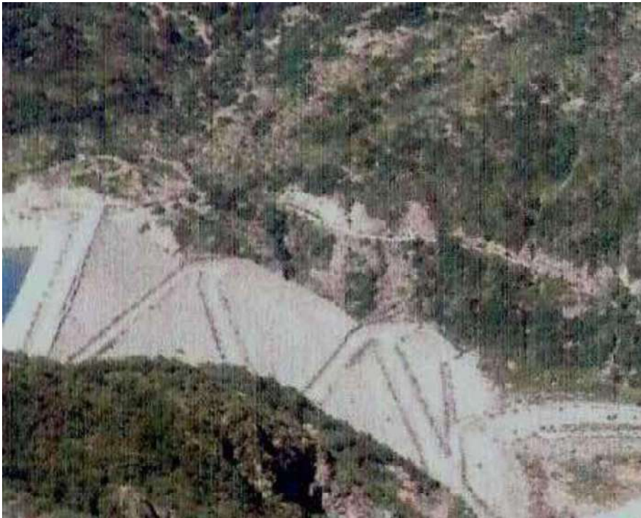
Vista dall'alto della diga di Colbun
