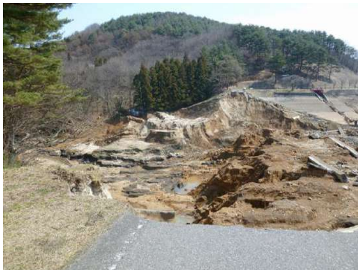
Figura 2 - Collasso della diga di Fujinuma (2011) [9].
