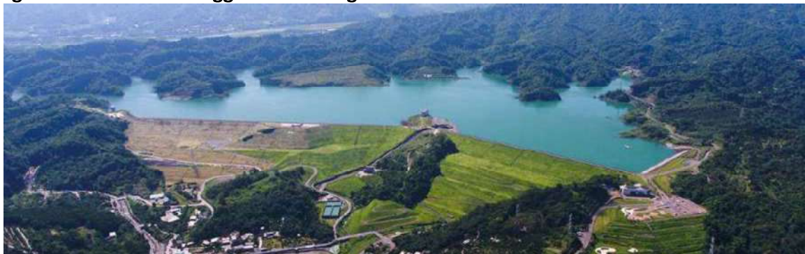
Vista da valle dello sbarramento
