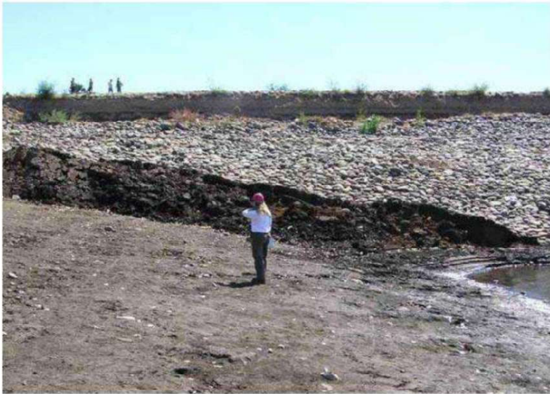
Cedimento A – Rigonfiamento (da Bray et al., 2010).
