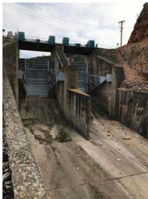
Vista di valle delle opere di scarico
