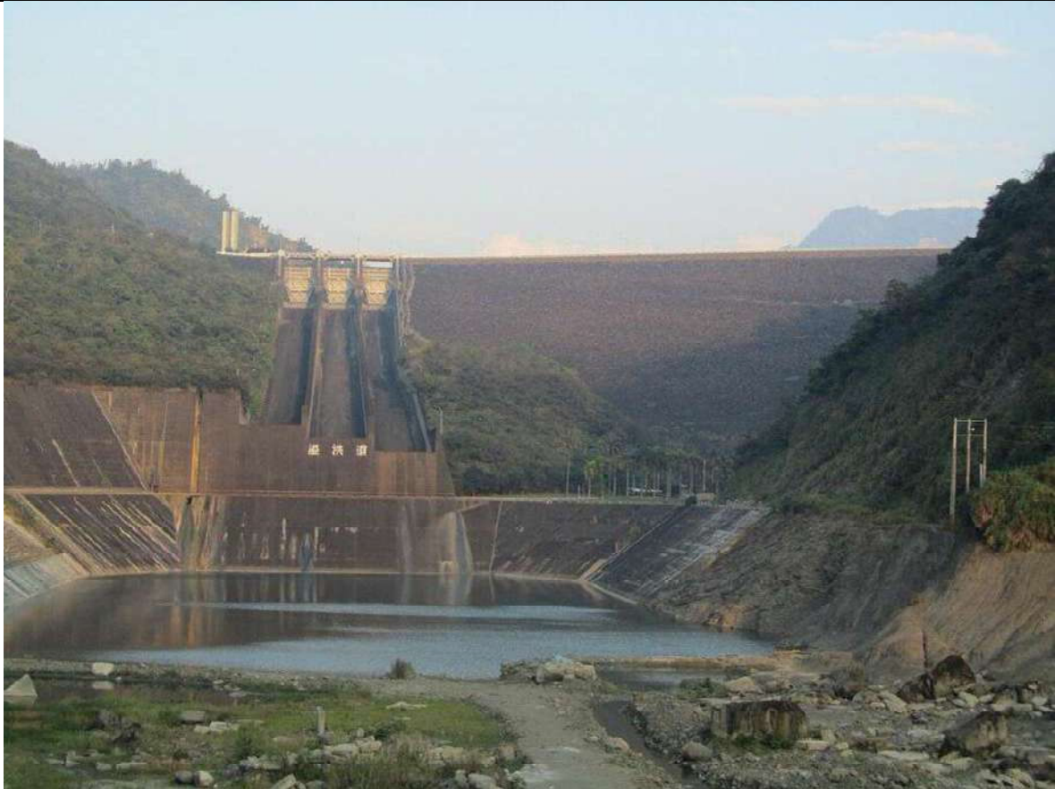
Vista da valle dello sbarramento
