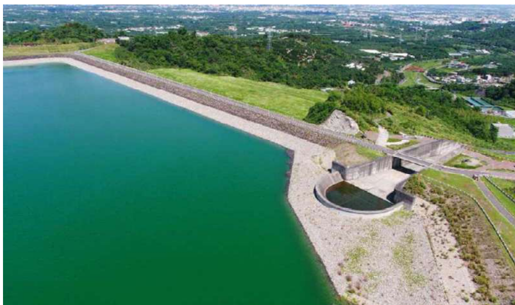
Sbarramento e opere di scarico superficiali, vista frontale
