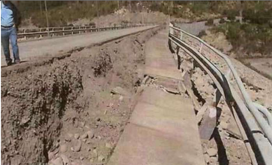
Spostamento del condotto elettrico in cresta (Noguera, 2010)
