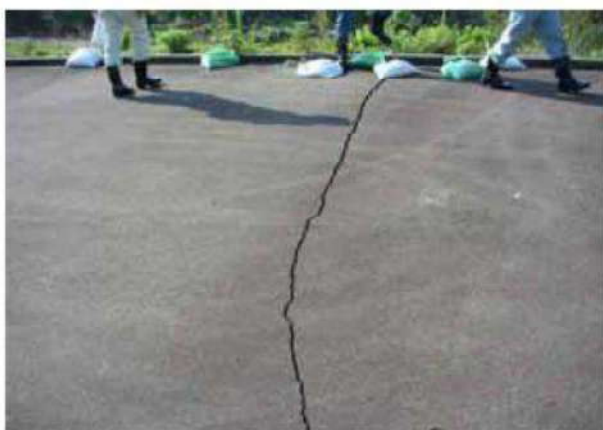
Danni osservati nella pavimentazione del coronamento
