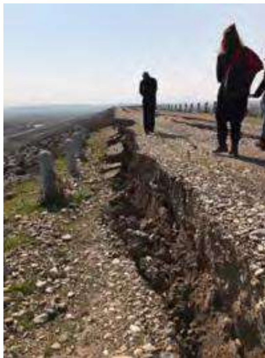
Fessure longitudinali in cresta
