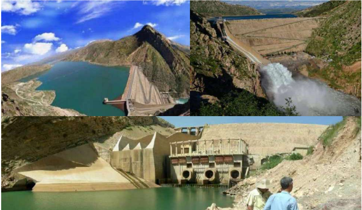
Figura 1: Darbandikhan Dam: vista aerea e viste da valle.
