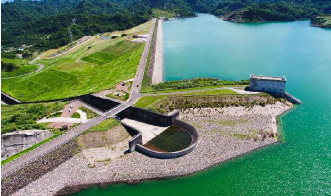
Sbarramento e opere di scarico superficiali, vista laterale
