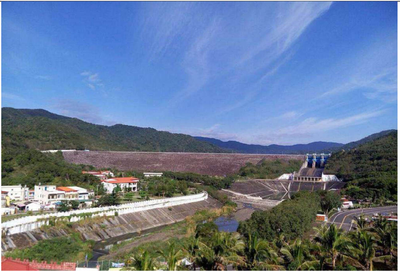
Vista da valle dello sbarramento
