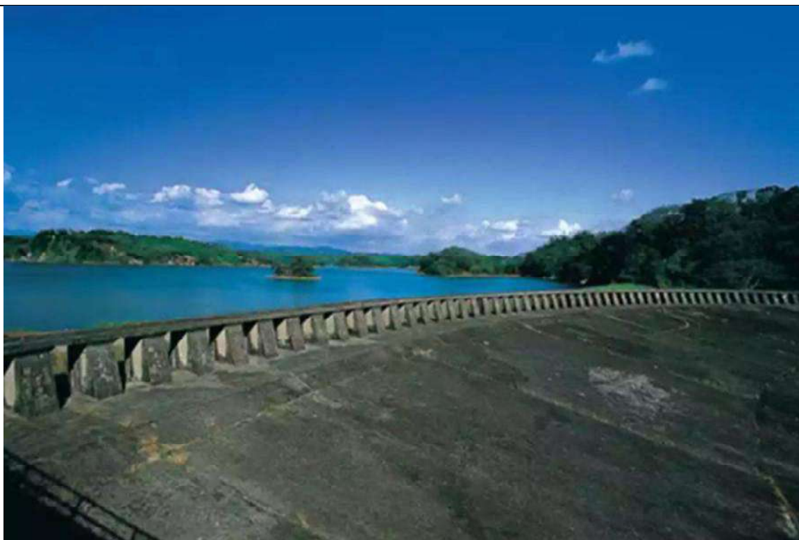
Vista da valle dello sbarramento
