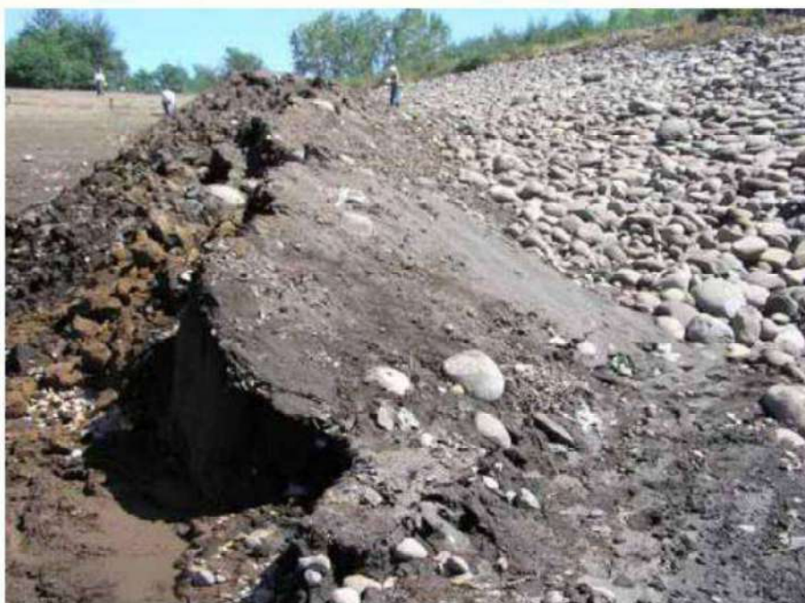
Vista laterale del rigonfiamento (da Bray et al., 2010).
