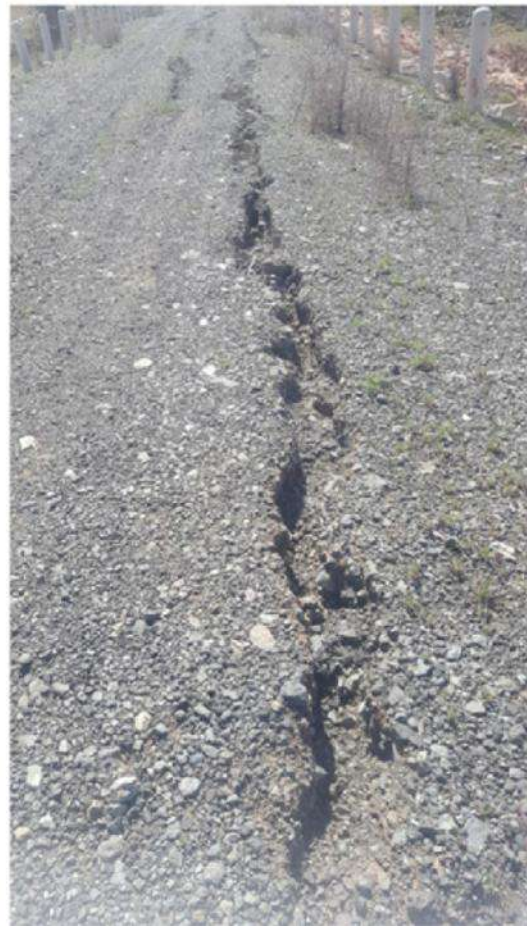
Fessure longitudinale rilevate a seguito del sisma del 06/02/2023
