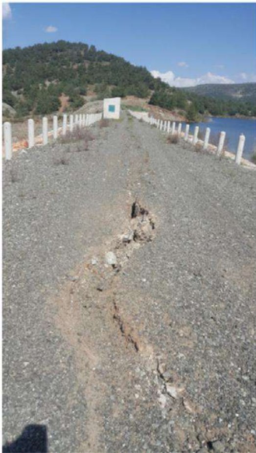
Fessure longitudinale rilevate a seguito del sisma del 06/02/2023
