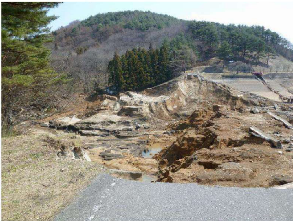
Fotografia dopo il collasso della diga principale
